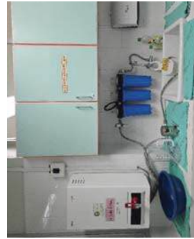
ภาพที่ 9 เครื่องกรองน้ำเคมีบำบัด ชั้น 1 (อาคารป็นรักษ์)
